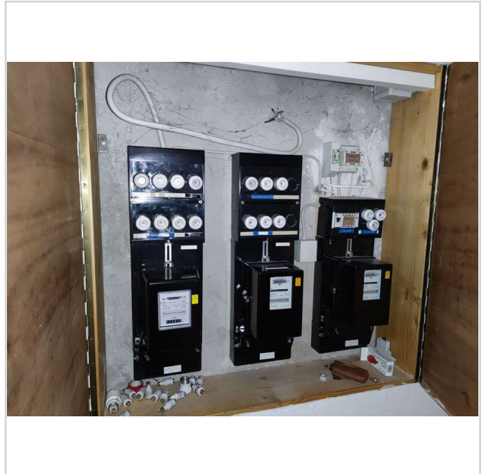
Stromverteiler
